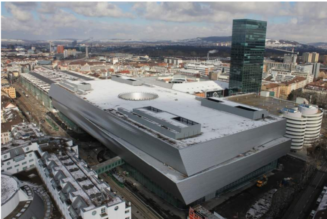
Bild 2 Luftaufnahme Neubau Messe Basel (Quelle: www.mch-group.com )
