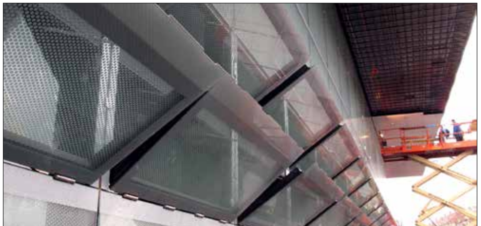
Simulierte Auslösung eines Brandmelders zur Kontrolle der Brandfallsteuerungen (Abb. Rauch- und Wärmeabzugsanlage)
