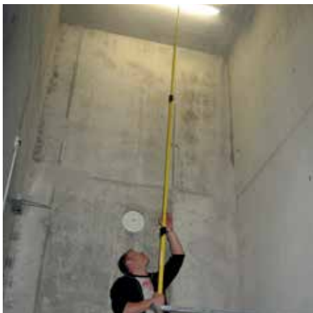
Simulierte Auslösung eines Brandmelders zur Kontrolle der Brandfallsteuerungen (Abb. Rauch- und Wärmeabzugsanlage)
