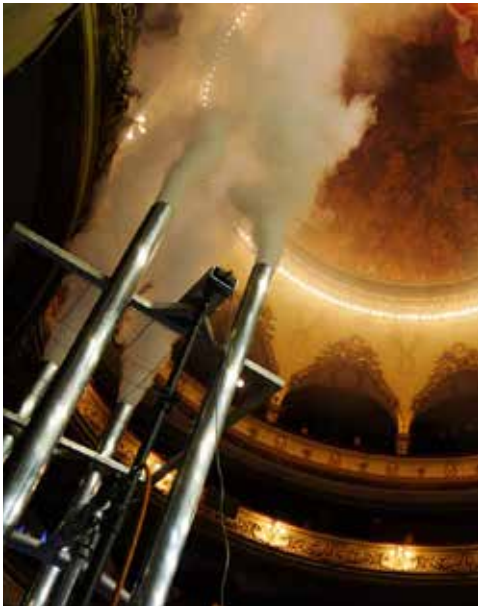
Überprüfung der Bestandssituation im historischen Theater Bern (Denkmalschutz) durch einen Warmrauchversuch
